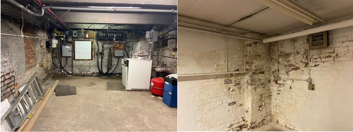
Photos h) i) j) k) The existing basement of Reedham House
